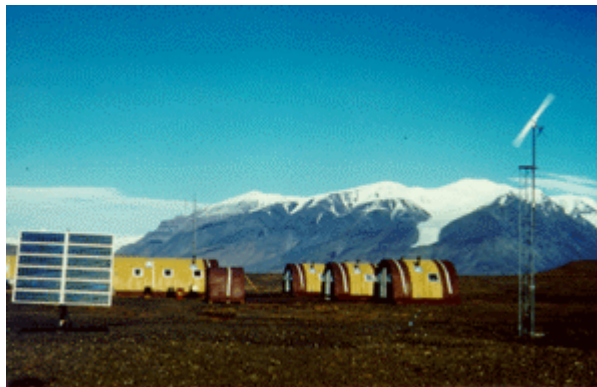
Générateur photovoltaïque d'un système hybride installé au poste des gardes du parc national de l'île-d'Ellesmere dans l'Arctique canadien
